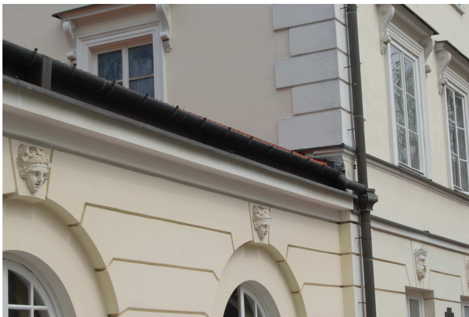
Fot.31. Widoczne obróbki blacharskie okapu i rynny niższej części budynku. Stan techniczny dobry. Skutecznie chronią gzyms ze sztukatorskim wystrojem przed wodą opadową. Wymagają dokładnego obejrzenia w trakcie prowadzonych robót i ewentualnych uzupełnień lub wymian fragmentów zniszczonych.
