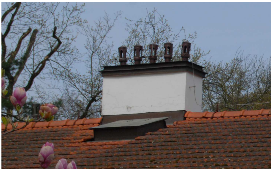
Fot.31. Komin wentylacyjny niższej części dachu. Stan techniczny bardzo dobry. Obróbki blacharskie komina również dobrze zachowane. Istniejący wyłaz dachowy, instalacja odgromowa – w stanie dobrym. Wymagane jest zainstalowanie stopni kominiarskich prowadzących od okapu w kierunku wyłazu.
