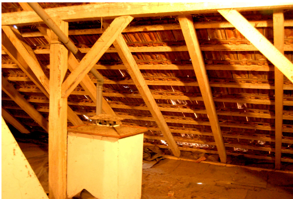
Fot.05. Jak wyżej – połacie wschodnia. W górze połaci widoczny wyłaz dachowy o nieszczelnym pokryciu, wymaga regulacji na zawiasach. Instalacja odgromowa w stanie bardzo dobrym. Z tej strony budynku również dobrze zachowane obróbki blacharskie – należycie osłaniają sztukatorskie zdobienia gzymsu wieńczącego.
