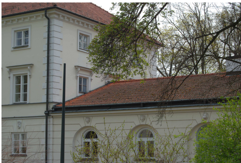
Fot.23. Widoczna północna połać dachu. Podobnie jak w połaci zachodniej, stan dachówki bardzo zły, kwalifikuje się do wymiany. Opasująca dach rynna, podrynnowy fartuch i pozostałe obróbki blacharskie w stanie dobrym.
