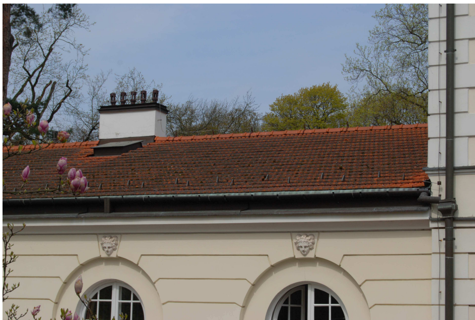
Fot.21. Zbliżenie południowej połączki dachu. Widoczny stosunkowo dobry stan zachowania pokrycia. Murowany komin zawierający przewody wentylacyjne w stanie dość dobrym. Dobrze zachowanie nakrywa komina i wentylacyjne wywiewki wykonane z miedzianej blachy.
