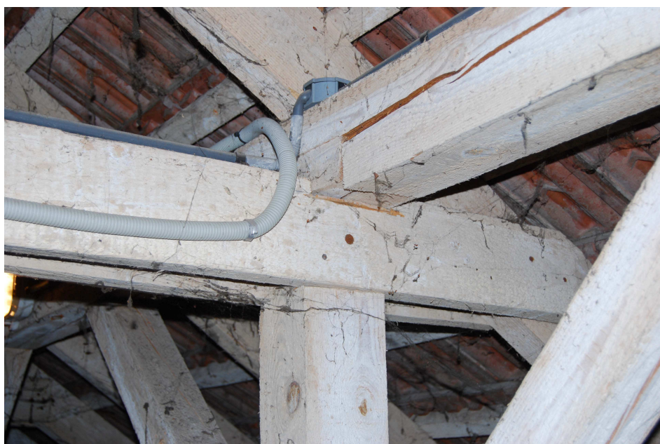
Fot.17. Jak wyżej. Widoczne wzdłużne pęknięcia płatwi. Po powierzchni drewnianych elementów więźby prowadzone są instalacje: słaboprądowe (instalacja detekcji dymu, sygnalizacji alarmu pożarowego) i oświetleniowe. Podczas prac remontowych należy zwrócić uwagę na zabezpieczenie i ochronę tych instalacji przeciwko uszkodzeniom.
