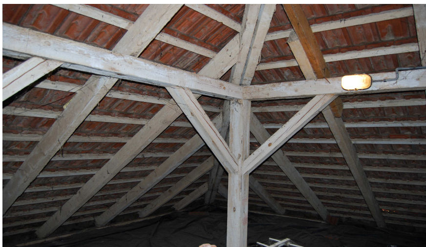
Fot.14. i 15. Krokwie wspierają się na konstrukcji płatwiowo-kleszczowej. Płatwie o przekrojach 14 x 14 cm, słupki 14 x 14 cm, miecze 10 x 10 cm, krokwie 14 x 7 cm, kleszcze 2 x 15 x 7,5 cm. Krokwie narożne zbijane z przekładkami 2 x 14 x 8 cm. Stan techniczny więźby dobry. W niektórych miejscach widoczne wzdłużne pęknięcia krawędziaków powstałe wskutek wysychania drewna. Pęknięcia są ustabilizowane, nie zagrażają stabilności i nośności więźby.
