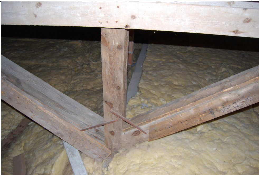
Fot.26. Widoczna izolacja z wełny mineralnej ułożonej na stropie nad pomieszczeniami użytkowymi jest zachowana w stanie bardzo dobrym. Widoczne spód konstrukcyjnego stolca drewnianej więźby – również suchy, bez śladów niszczącej wilgoci.
