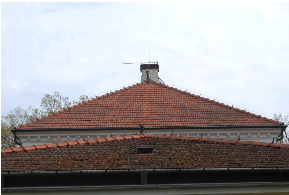
Fot.22. W spodzie fotografii – zachodnia połać niższej części budynku. Stan dachówki bardzo zły, kwalifikuje się do natychmiastowej wymiany. W osi połaci okienko dymnikowe opierzone miedzianą blachą w stanie niezłym.
