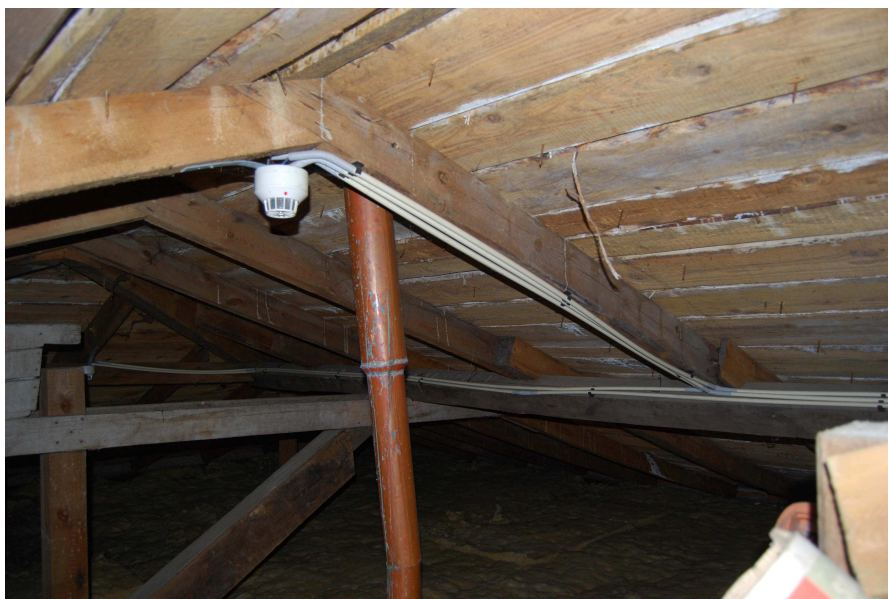
Fot.24. Dach niższej części budynku widoczny od spodu, z wnętrza poddasza nieużytkowego. Pokrycie dachu układane jest na deskowym sosnowym poszyciu o grub. 20 mm, na którym położona jest warstwa papy, sosnowe łąty i zakładkowa dachówka ceramiczne. Warstwa papy zapewnia dobrą szczelność poszycia, co skutecznie chroni poddasze, konstrukcję więźby i ułożoną na stropie nad parterem izolację z wełny mineralnej.
