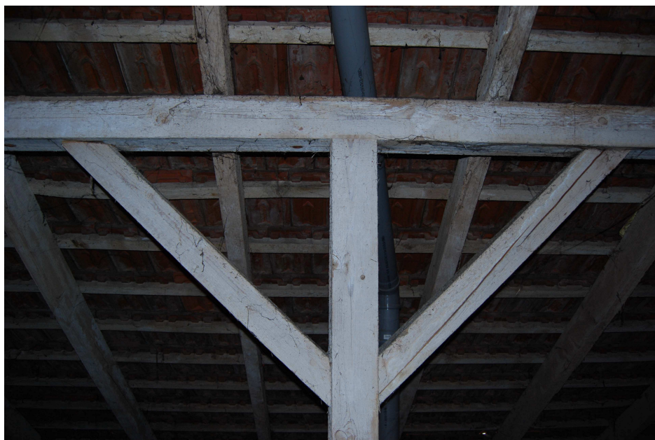
Fot.16. Jak wyżej. Wszystkie drewniane elementy więźby są zabezpieczone przeciwogniowo i przeciwko biologicznym szkodnikom impregnatami. W niektórych miejscach widoczne są pęknięcia wzdłużne elementów więźby – tu pęknięcia miecza. We wskazanych w projekcie miejscach należy pęknięcia zespolić za pomocą ściągów stalowych.
