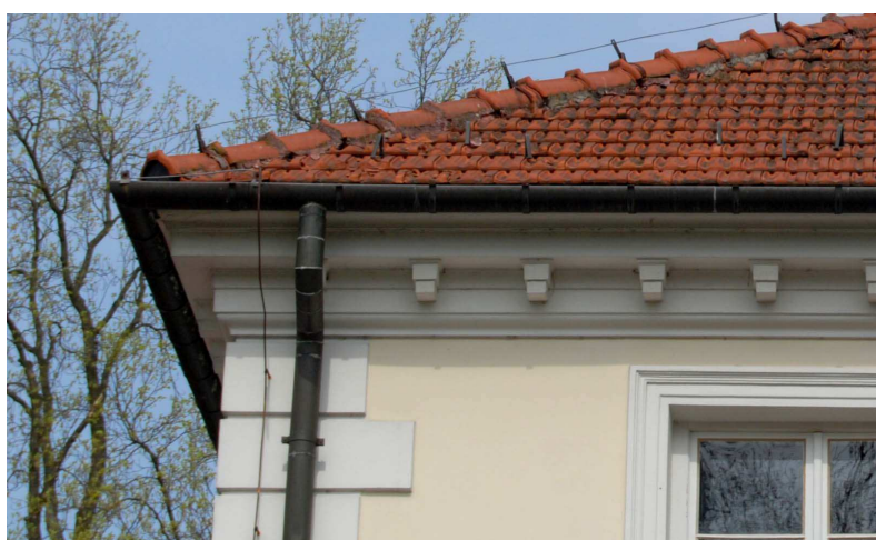
Fot.29. Widoczny fragment obróbek blacharskich opasujących dach korpusu głównego – rury spustowe, wiszące rynny i nadrynnowy fartuch zachowane są w stanie dość dobrym, wymagającym przejrzania i uzupełnienia uszkodzeń i ubytków. W stanie dobrym jest instalacja odgromowa. Tynki sztukatorskiego gzymsu – bez uszkodzeń, rozwarstwień i ubytków.
