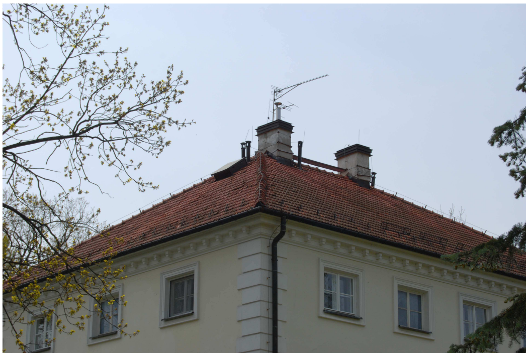
Fot.04. Krawędź połaci północnej i wschodniej. Widoczne zniszczenia dachówek. Gąsiory układane za zaprawę. Obróbki blacharskie w stanie dość dobrym.
