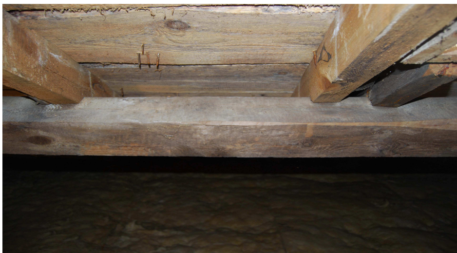
Fot.28. Widoczne zaciosy krokwi wspierających się na drewnianych płatwiach. W miejscach oparcia krokwi brak śladów uszkodzeń i zniszczeń. Płatwie nienaruszone wilgocią, grzybami i działaniami innych biologicznych szkodników. Deskowanie zdrowe, nadające się do pozostawienia w swoim miejscu, po dokonaniu uzupełnień podczas remontu w miejscach, zniszczonych, ujawnionych po rozbiórce pokrycia.
