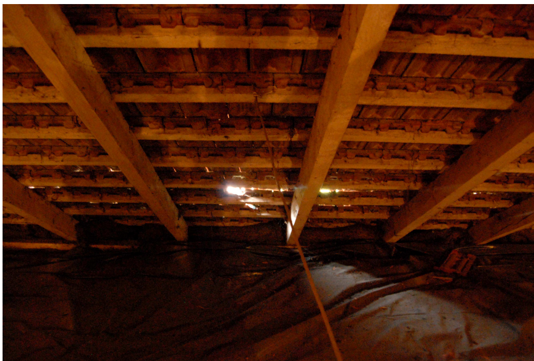
Fot.08. Połać wschodnia. Widoczne od wnętrza poddasza dziury w pokryciu dachowym. Przez
