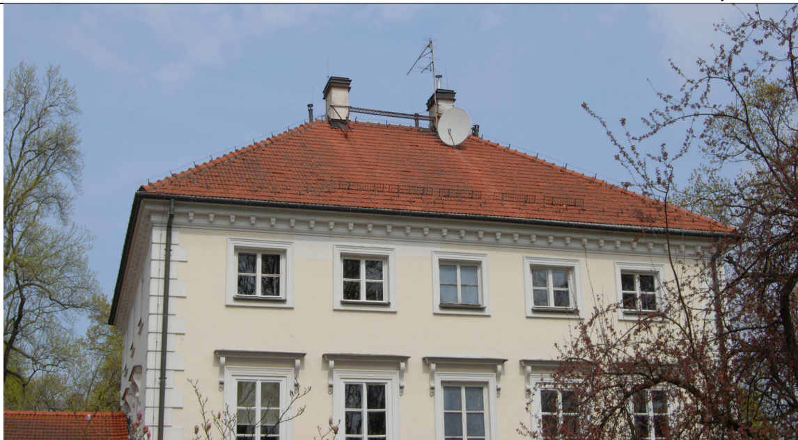
Fot.01. Południowa połąć dachu nad głównym korpusem budynku. Okap dachu wspiera się na profilowanym gzymsie zabezpieczonym blacharskimi obróbkami. Widoczne elementy wyposażenia dachu: ławy kominiarskie, anteny telewizyjne, drabinki śniegowe i wywiewki kanalizacyjne.
