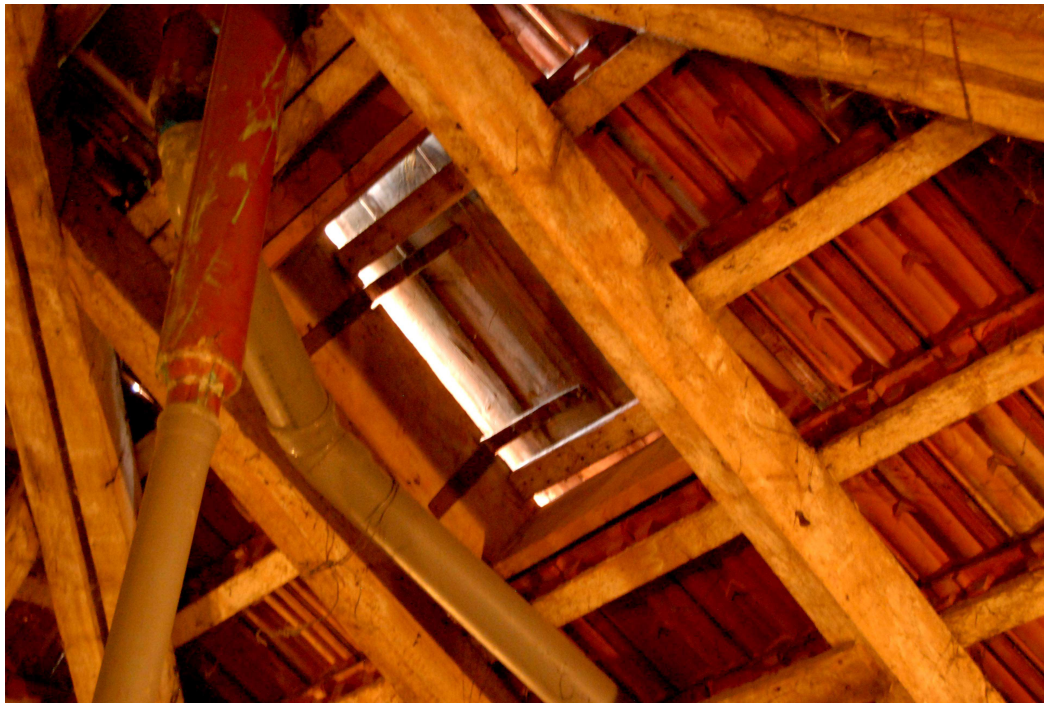
Fot.09. Połąć wschodnia. Kłapa włazu na dach – rozregulowane zamknięcie na zawiasach uniemożliwia szczelne zamykanie otworu, co również przyczynia się do zalewania poddasza wodą.
