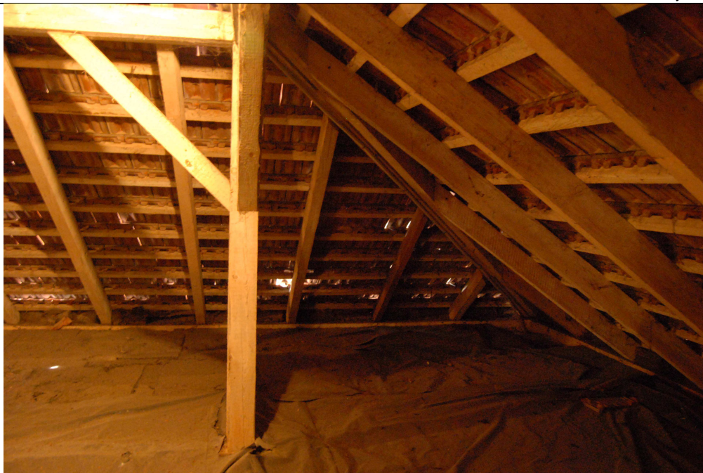
Fot.06 i 07. Pokrycie dachówką widoczne od spodu dachu. Bezpośrednio do krokwi mocowane są na gwoździe sosnowe łaty. Na łatach ułożone dachówki zakładkowe. Brak izolacji przeciwwiatrowej. Na obu fotografiach widoczne są dziury w zniszczonych, złej jakości dachówkach. Przez ubytki z zewnątrz zacieka woda opadowa. W spodzie fotografii widoczna folia ułożona na warstwie izolacji z wełny mineralnej ocieplająca strop ponad niższą położoną kondygnacją użytkową. Folia zabezpiecza izolację z wełny przed zamakaniem.
