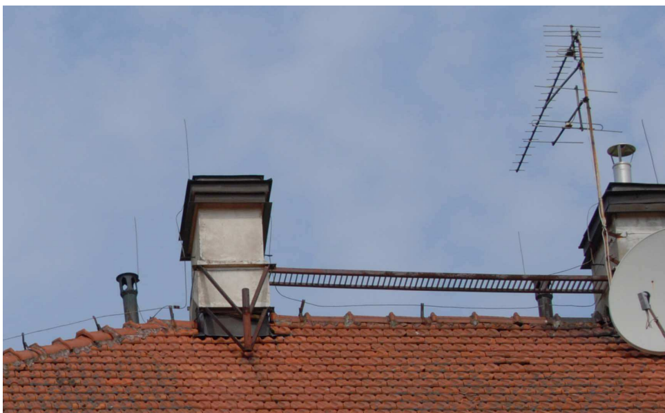
Fot.30. Kominy wentylacyjne na dachu korpusu głównego. Remontu wymagają tynki kominów. Obróbki blacharskie są w stanie dobrym. W dobrym stanie technicznym jest istniejąca ława kominiarska i instalacja odgromowa. Obie istniejące anteny telewizyjne i pozostałe instalacje i wyposażenie dachu należy zdemontować na czas prowadzonych prac.
