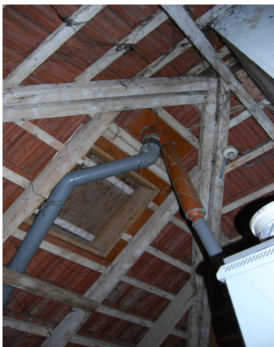
Fot.19. W strefie poddasza prowadzone są instalacje sanitarne. Tu widoczne odpowietrzenia pionów kanalizacji. W wielu miejscach wywiewki mocowane są do drewnianej więźby. Po zakończonych pracach Wykonawca robót powinien zadbać o ponowne solidne zamocowanie przewodów kanalizacyjnych do istniejących lub nowych elementów konstrukcji dachu. Przebicia połaci dachowych w miejscach przejść instalacyjnych powinny zostać należycie uszczelnione przed przeciekami.
