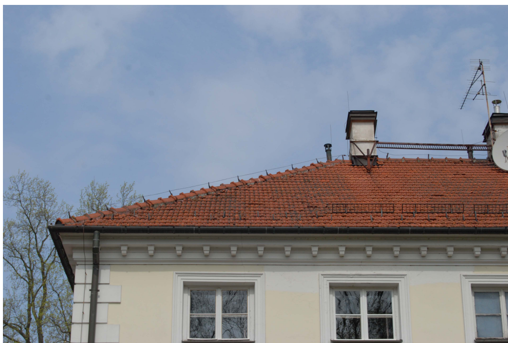
Fot.02. W powiększeniu fotograficznym dostrzega się nieszczelności powstałe w ceramicznym pokryciu. Są one spowodowane zużyciem dachówek – złusowane, zmurszałe, pokruszone wskutek termicznych ruchów. Wykonane są ze złej jakości materiału. Kwalifikują się do usunięcia.
