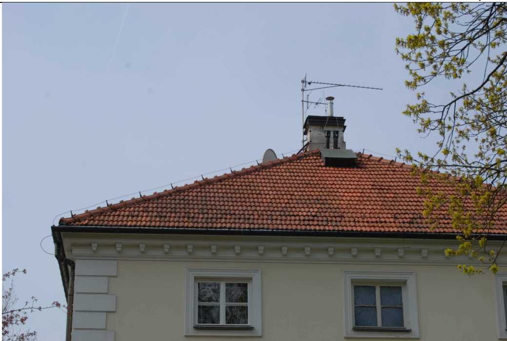
Fot.05. Jak wyżej – połacie wschodnia. W górze połaci widoczny wyłaz dachowy o nieszczelnym pokryciu, wymaga regulacji na zawiasach. Instalacja odgromowa w stanie bardzo dobrym. Z tej strony budynku również dobrze zachowane obróbki blacharskie – należycie osłaniają sztukatorskie zdobienia gzymsu wieńczącego.
