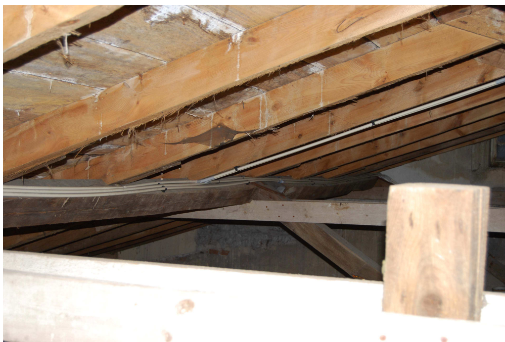
Fot.27. W podobnie dobrym stanie są zachowane krokwie więźby dachowej. Leżące na nich poszycie z sosnowych desek również suche i bez śladów zniszczeń. W szczelinach pomiędzy luźno położonym deskowaniem widoczna jest warstwa papy izolacyjnej, która skutecznie chroniła konstrukcję i izolację przed wodą opadową. Stan papy należy sprawdzić po zdemontowaniu istniejącego pokrycia z ceramicznej dachówki zakładkowej i określić zakres uzupełnienia i ewentualnej wymiany papy.
