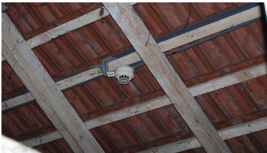
Fot.18. Jak wyżej. Widoczna instalacja detekcji dymu i czujka dymowa. Instalacja w tym wypadku jest prowadzona po powierzchni łąt niosących dachówki. Łaty podczas remontu dachu zostaną zdemontowane. Dlatego instalacje w tych miejscach powinny zostać tymczasowo zdemontowane i ponownie ułożone na nowych elementach drewnianych zastępujących zdemontowane łaty. Po zakończonych robotach wymagane jest sprawdzenie stanu instalacji i usunięcie ewentualnych usterek.
