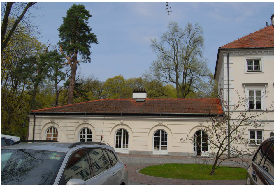
Fot.20. Widoczna południowa połączka dachu zachodniej, parterowej części budynku. W sąsiedztwie komina widoczna kłapa włazowa na nieużytkowe poddasze, do którego dostępu z wnętrza nie ma.
