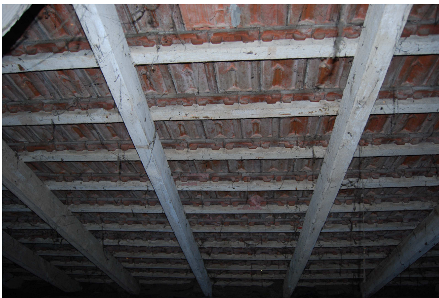
Fot.13. Pokrycie z ceramicznej dachówki kładzonej na łątach mocowanych bezpośrednio do krokwi o wymiarach 14 x 7 cm. Rozstaw krokwi średnio co 90 cm. Krokwie zachowane w dobrym stanie technicznym. Widoczny spód zniszczonych zakładkowych dachówek. Brak izolacji wiatrowej i pełnego poszycia nie daje pełnego zabezpieczenia przeciwwodnego.
