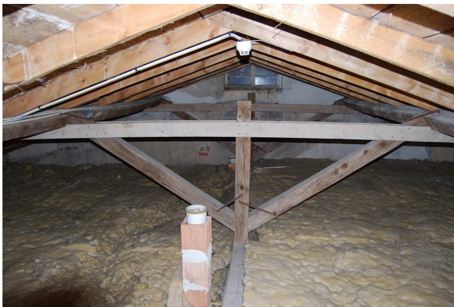
Fot.25. Widoczne elementy konstrukcyjne więźby są w stanie bardzo dobrym. Nie występują wzdłużne spękania, drewno jest suche, brak śladów spruchnień.
